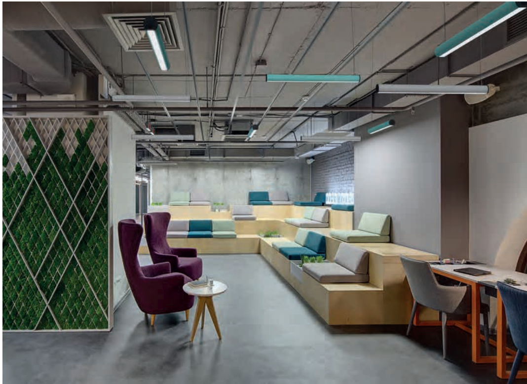
Espacios con instalaciones vistas (sin falso techo).
