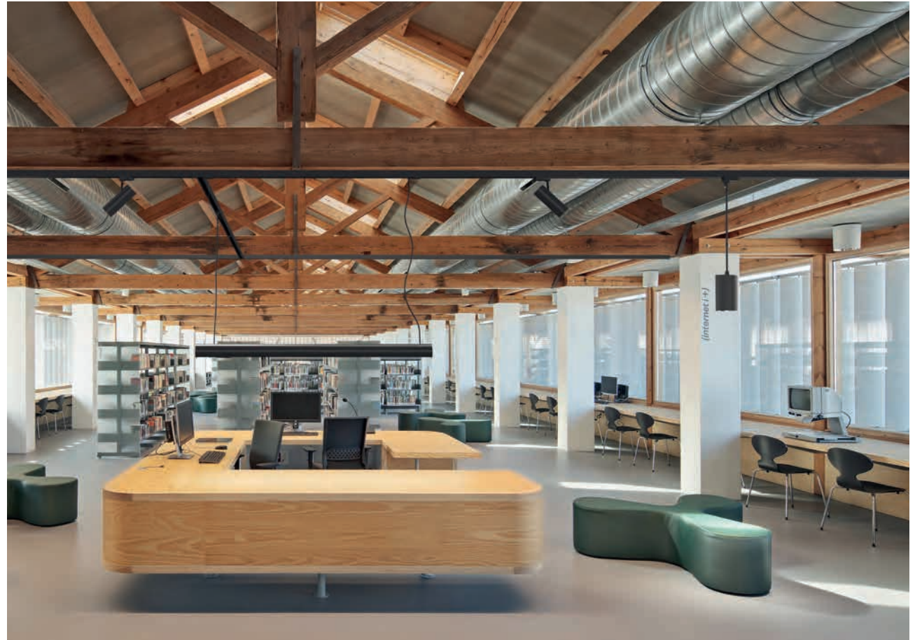
Espacios rehabilitados (Integración en estructuras existentes).
